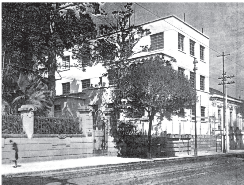
Pavilhão de Química em término de construção, 1938 – Alameda Glette
